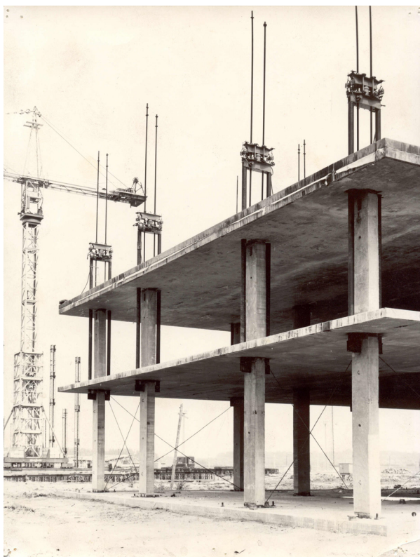
LIFT-SLAB technológiával készülő irodaház földemelezei
