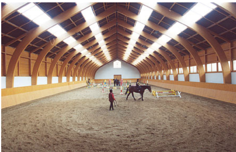
Ragasztott fatartókból kialakított háromcsuklós tartók
