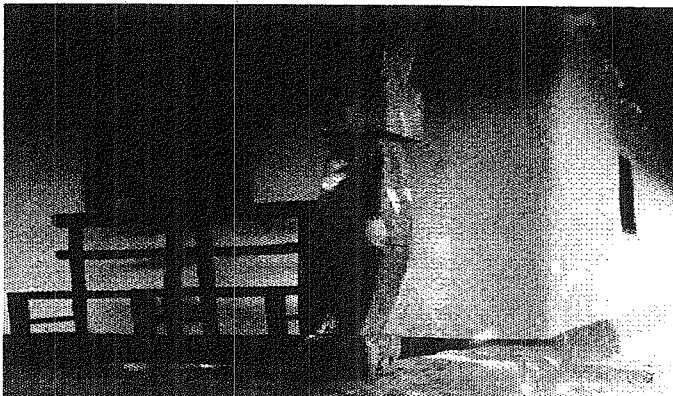
22.kép Tonácrészlet a Kistrécse, Rákóczi út 2. sz alattihajlékról, jól látható a talpgerenda.
