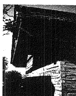
10.kép Fecskefarkas rovással kialakított boronafal.
