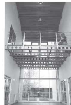
Abbildung 9: Glasbrücke als Verbindungselement zwischen Labortrakt und Institutsgebäude am Institut für Hochbau und Technologie, Zentrum für Baustoffforschung, Werkstofftechnik und Brandschutz an der TU Wien, Fotos: Aufnahmen der Verfasser
