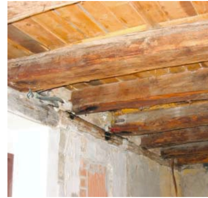
Bild 5: Chemische Holzschutzmaßnahmen an einer gefährdeten Holztramdecke über KG (das Aufbringen der Holzschutzmittel erfolgte im Bohrlochtränkungsverfahren).
