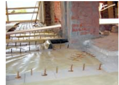
Vorbereitung der Verbundverstärkung: Auflegen einer Feuchtigkeitsabdichtungsfolie und einschrauben der Verbindungsmittel.
