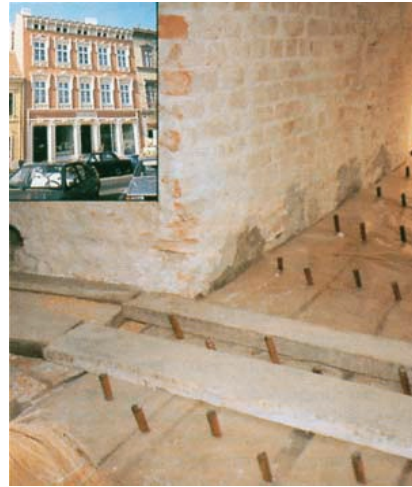
Bild 4: Verstärkung einer sanierungswürdigen Tramdecke mit Stahlfaserbetondruckgurt im ehemaligen Stadtpalais Szöllösy (Sopron/Odenburg).
