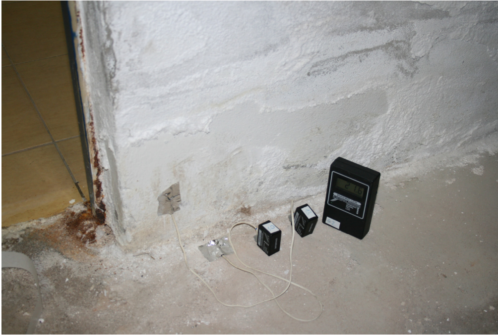
Foto č. 2 Pohľad na meracie zariadenie
