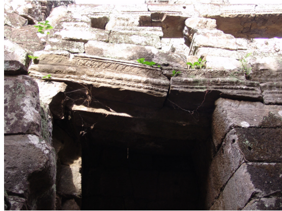
Obr. 5 Narušené paty sloupů vystavených vlhkosti (chrám Angkor Vat); zlomené nadpraží, posun levého ostění vůči pravému (chrám Bayon, konec 12. stol.)
