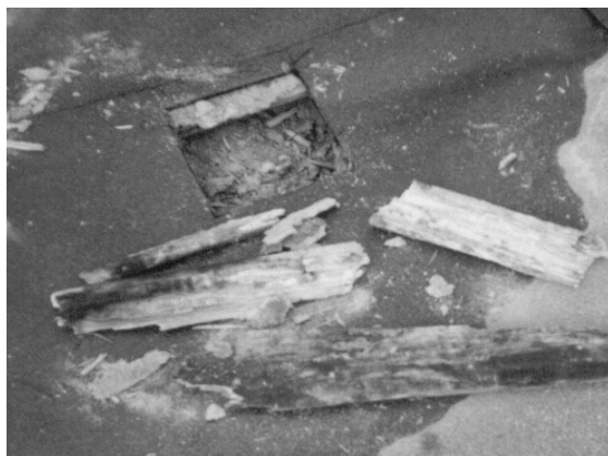
Obr. 2. Odstraňovanie prehnitých častí debnenia, drevokazná huba, 5 rokov užívania
