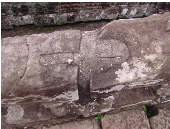
Obr. 7 Propojení původně samostatných kamenných kvádrů do jednoho celku (chrám Bayon); nahrazení lateritové stěny železobetonovou stěnou (chrám Baphuon)
