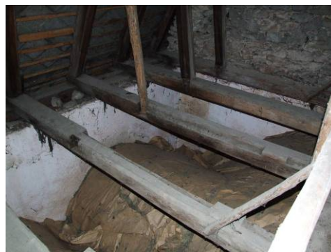
Obr. 8 Belá Dulice, nárožné dlaby na väzných trámoch
