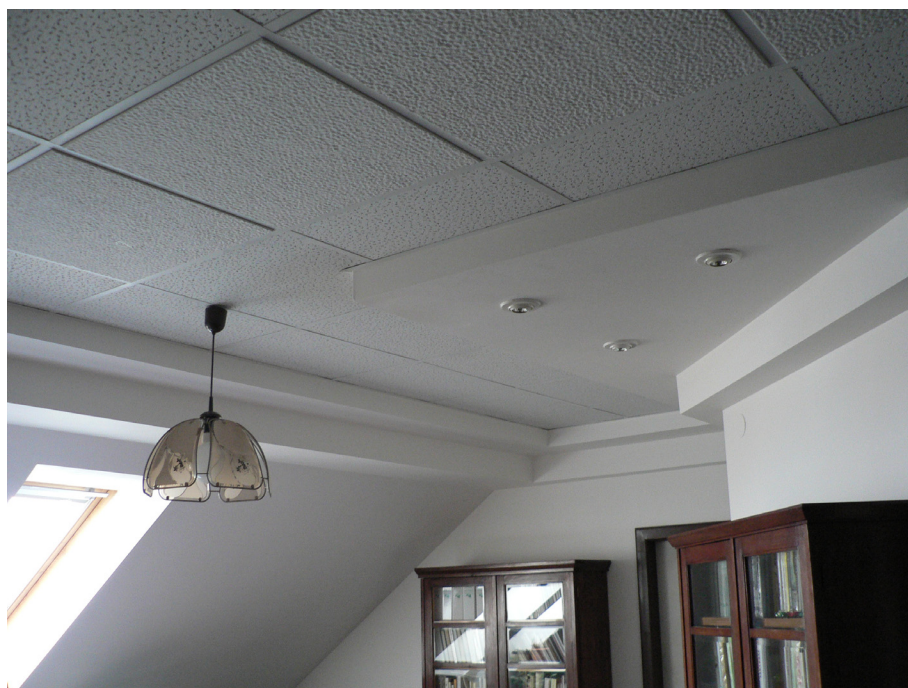
Obr.3 Složitě řešený podhled plynule navazuje na šikmé stěny vestavby.
