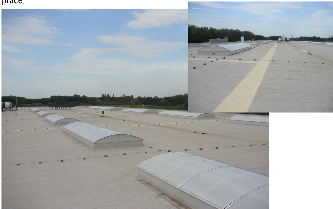
Obr. 1 – Obloukový polykarbonátový světlík
