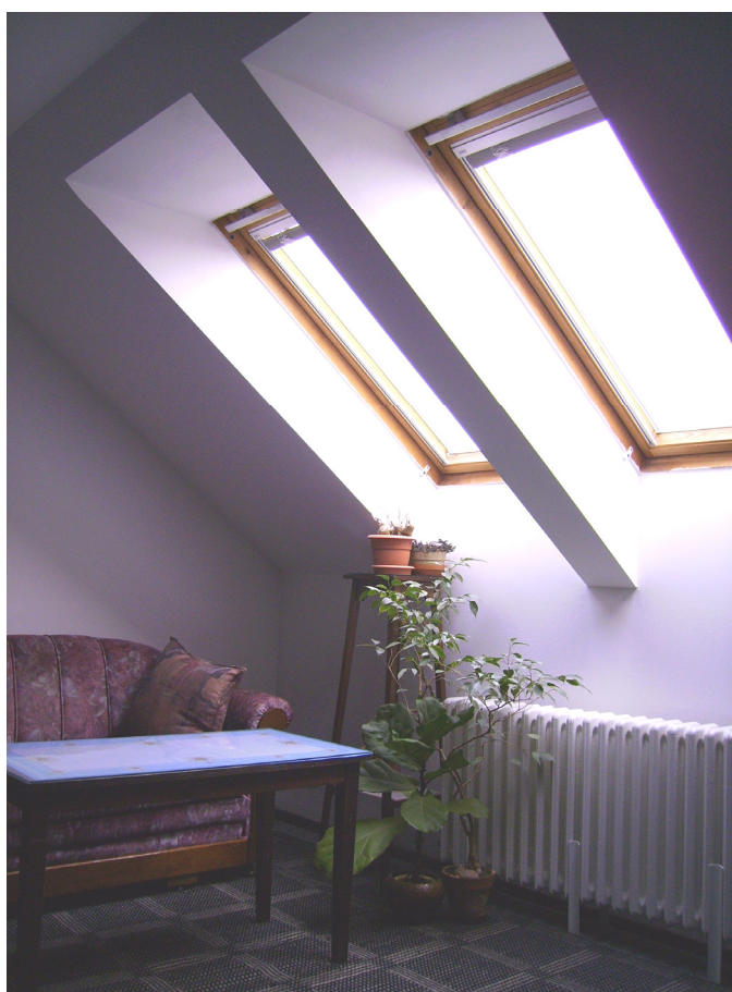
Obr.2 Vysoká nadezdívka zaručuje lepší využitelnost podstřešního prostoru.
