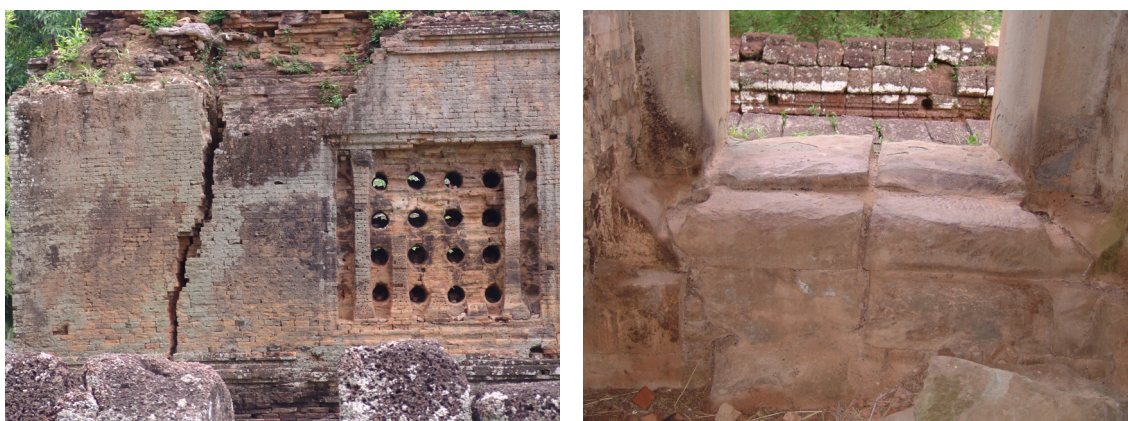
Obr. 4 Trhliny ve zdivu cihelné věže (chrám Bakong, konec 9. stol.); rozlomený kamenný práh cihelné věže (chrám Pre Rup)
