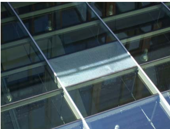
a) pohled na prosklený střešní plášť
