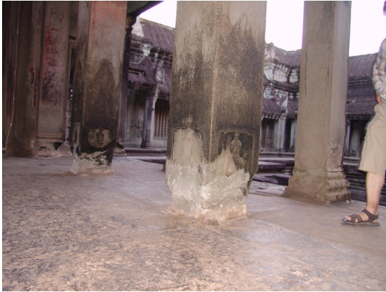
Obr. 5 Narušené paty sloupů vystavených vlhkosti (chrám Angkor Vat); zlomené nadpraží, posun levého ostění vůči pravému (chrám Bayon, konec 12. stol.)
