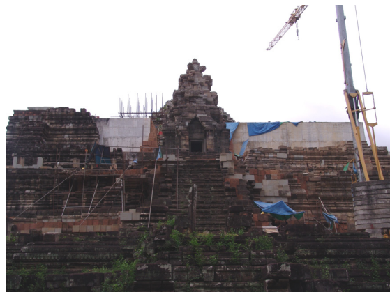
Obr. 7 Propojení původně samostatných kamenných kvádrů do jednoho celku (chrám Bayon); nahrazení lateritové stěny železobetonovou stěnou (chrám Baphuon)
