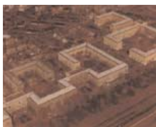
Megnyitott keretes, „szoc-reál” beépítés (Kerepesi úti lakótelep az 1950-es évekből)
