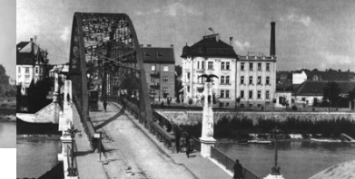
Az 1928-ben épült acélrácsos szerkezetű Révfalusi híd. Révfalu kapuja. Weinstock E., Bp. képeslapja, 1930-as évek.
