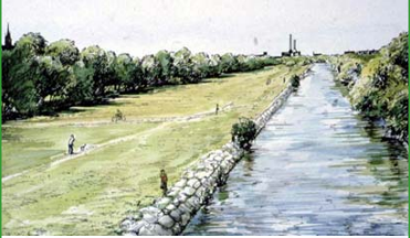
Rehabilitáció előtt és után
