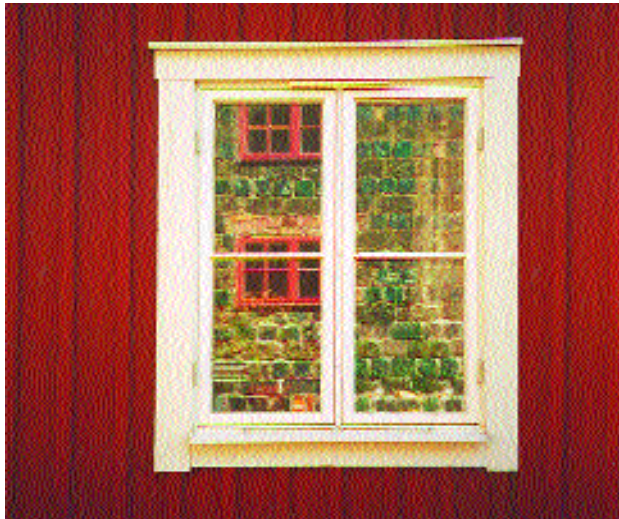
Baloldali képek: fent hagyományos burkolatba illesztett korszerű, szellőztetett ablak, a betekintés ellen védőfóliával, melyben a szembenlévő homlokzat részlete tükröződik. Lent: a hagyományos színű faburkolat mai épületnél. (skandináv példák)
