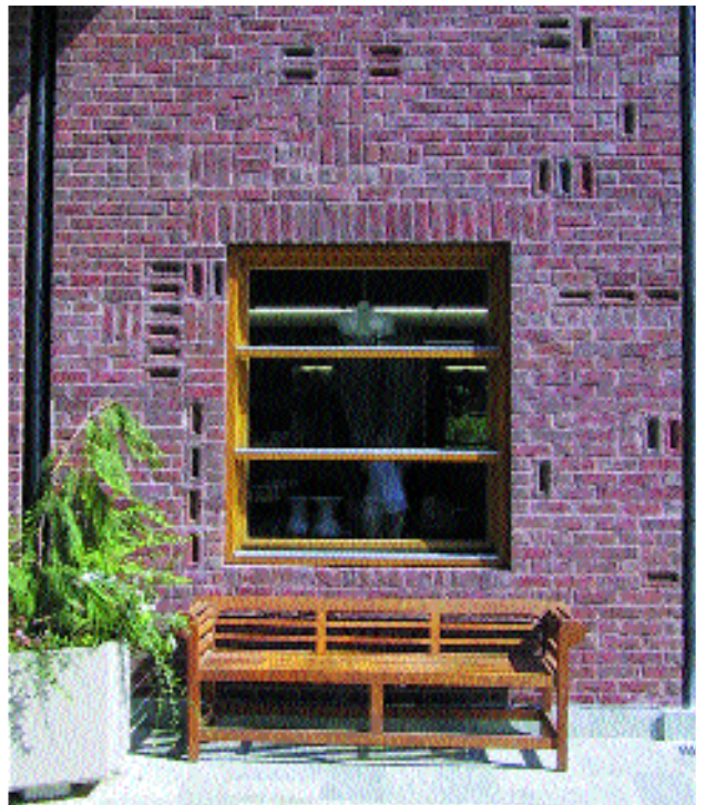
Baloldali képek: fent hagyományos burkolatba illesztett korszerű, szellőztetett ablak, a betekintés ellen védőfóliával, melyben a szembenlévő homlokzat részlete tükröződik. Lent: a hagyományos színű faburkolat mai épületnél. (skandináv példák)
