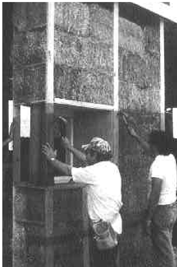
Nyílászárók keretezése. A felső képen kamraablak, jobbra lent létravázasszerkezet, balra lent a bálamérethez szélesített vaktok látható.
