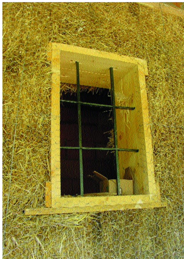
Nyílászárók keretezése. A felső képen kamraablak, jobbra lent létravázasszerkezet, balra lent a bálamérethez szélesített vaktok látható.
