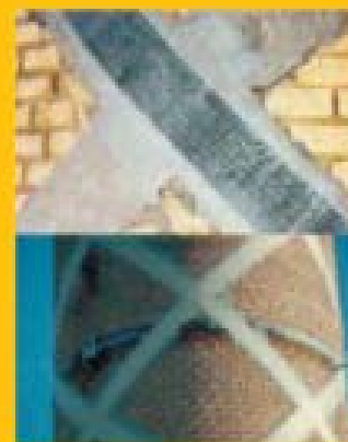
A szövet keresztezése és bevonatának elkészítése
