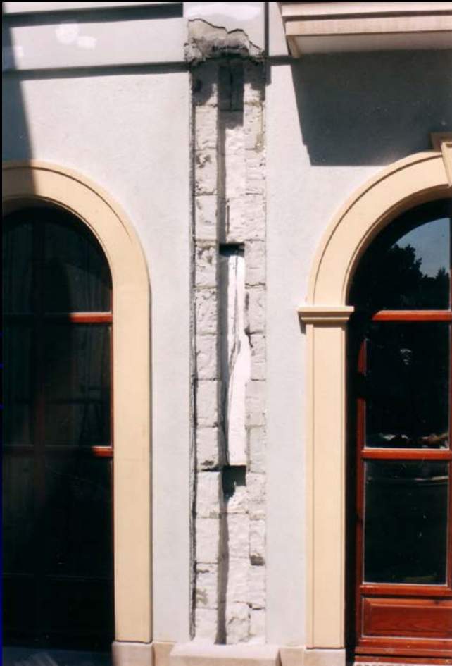
Az oszlop helyének kialakítása [2]
