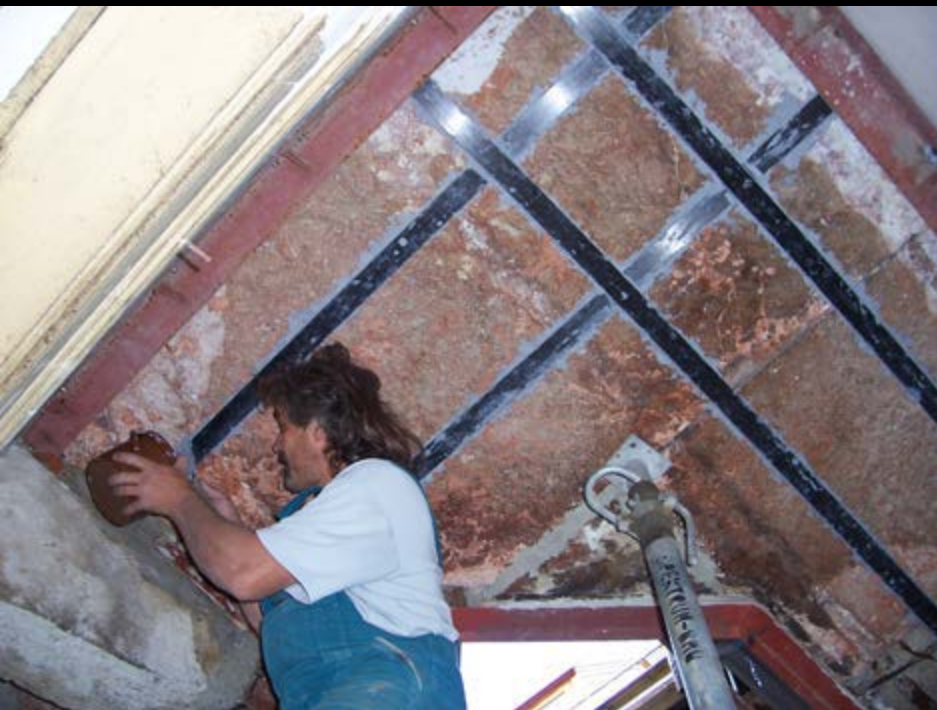
Törött lemezek lamellás erősítése [2]
