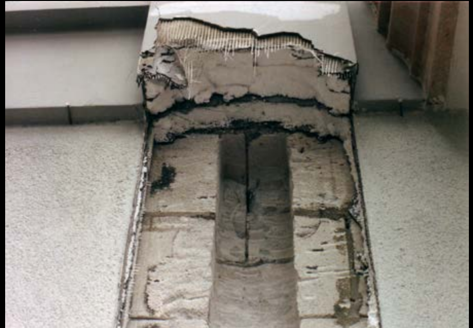
Az oszlop helyének kialakítása [2]
