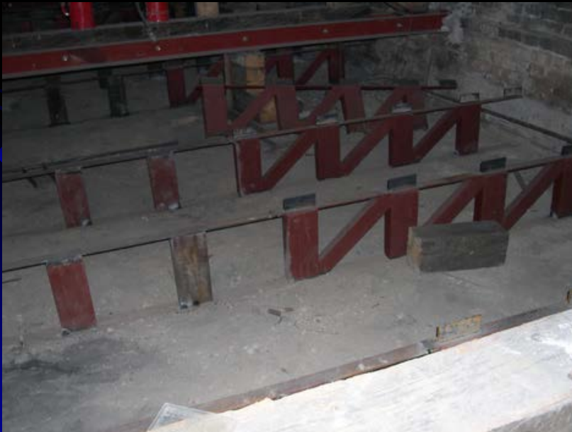
Lemez együtt dolgozó bekötéseinek elhelyezése
