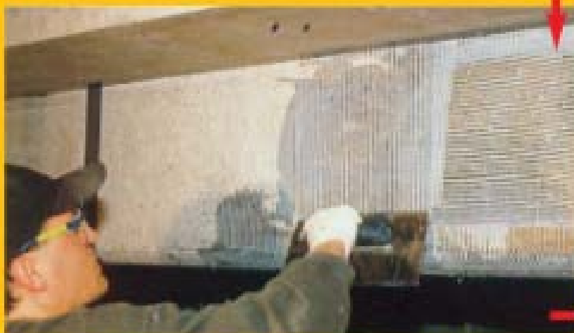
Sikadur®-330 ágyazó és ragasztóanyag felhordása az alapfelületre
