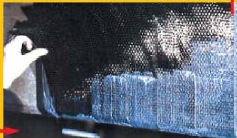
SikaWrap® szövet beágyazása a ragasztórétegbe. Pozicionálás, laminálás henger segítségével
