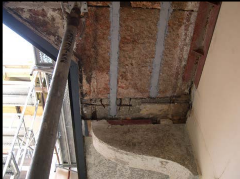
Lamellák habarccsal bevonva [2]
