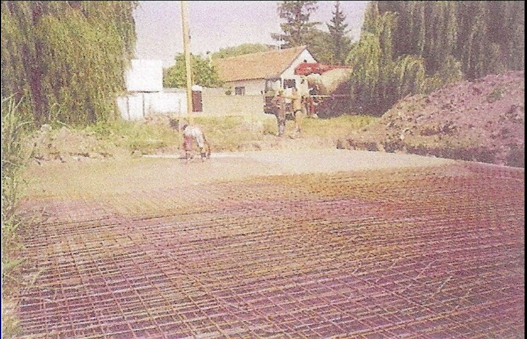
Vasbeton lemezalap készítése
