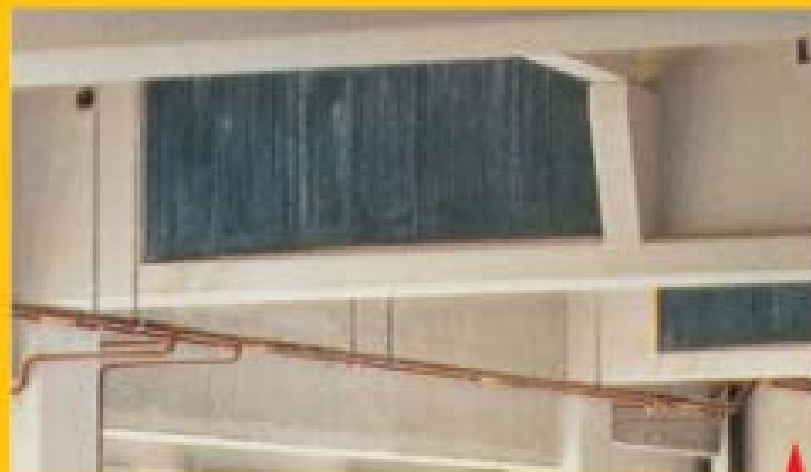
Az elkészült SikaWrap® szénszálás szövetmegerősítés
