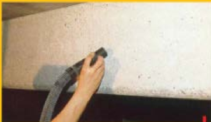
Az alapfelület előkészítése, tisztítása, portalanítása
