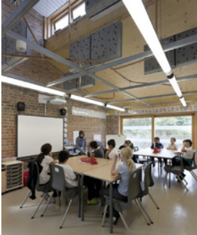
A Sandal Magna Általános Iskolában a látszó módon kialakított épületszerkezeti és gépészeti berendezések kialakítását gondos tervezés előzte meg. Büszkén mutatják meg magukat a függesztett hangszigetelő panelek, vagy az indaként a falon kúszó esővizet elvezető vezetékek, de kérdésekre ösztönözhetik a gyerekeket például az automata tűzoltó berendezés ívesen kigyózó vörösréz csövei is. A játékosság az osztálytermekben is folytatódik, ahol közlekedési lámpákba rejtett kijelzők mutatják ki az aktuális széndioxid-szintet.
