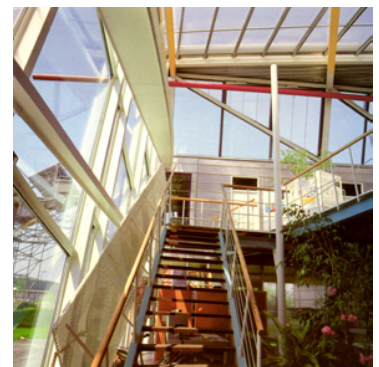
Az 1987-ben megvalósult, az építészeti szakirodalomban gyakran a dekonstruktivista építészeti egyik példaként azonosított Hysolar egyetemi épületben közelebbről megvizsgálva szembevetendő a használók iránti figyelem: fa padlóburkolat és ergonómikus korlát-fogódzó; napfényben úszó emberközeli léptékű és felfedezésre ösztönző terek; a világos árnyalatok mellett kis felületeken használt vidám színek, stb.
