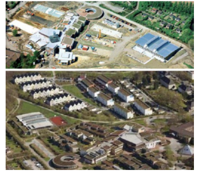
A Gelsenkircheni Evangélikus Iskola építés közben. A megvalósult épületkomplexum látszik a lenti kép alsó részén, míg felül a vele egy időben tervezett nyeregzetűs szolár-lakótelep és a szervezett kalákában alacsony jövedelmű családok által épített társasházak láthatók.
