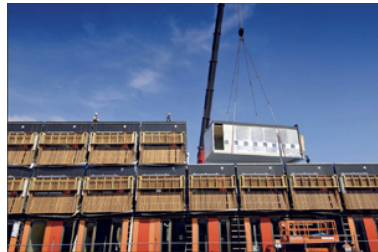
1. kép: A "Het e4" gimnáziumot előregyártott moduláris elemekből szerelték össze.
