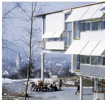
A könnyed megjelenésű lorchi iskolaépület bejárat előtti zónáját a pillért körülölelő egyedileg tervezett széles körpad teszi "jó helyé" (Progymnasium Lorch, 1973)
