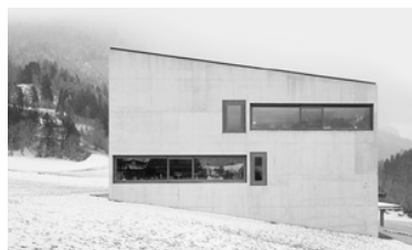
A paspelsi iskola emeleti alaprajza és külső nézete (megvalósulás éve: 1998; tervező: Valerio Olgiatti)
