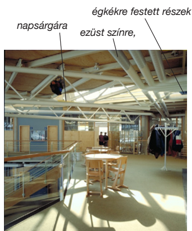
Az őszintén megmutatott, barkácsoltnak ható acél rácsostartót a fehér alapszín könnyedebbé, a bizonyos helyeken spontánul használt ezüst, égbék és napsárga színek pedig emberközelibbé teszik. (Hauptschule Lorch, 1982)
