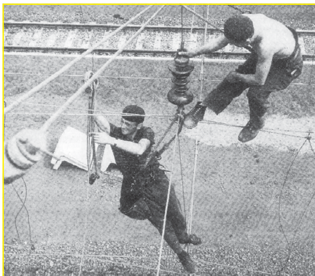
Villamos felsővezeték szerelés
