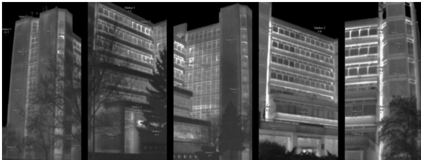
6. ábra: Az oktatási épület termografikus felvételei, a világos tónusok mutatják a magasabb hőmérsékletű felületeket (16)
