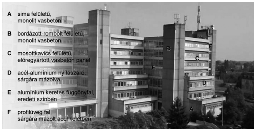
2. ábra: A tanulmányi épület homlokzati struktúrái és szerkezetei
