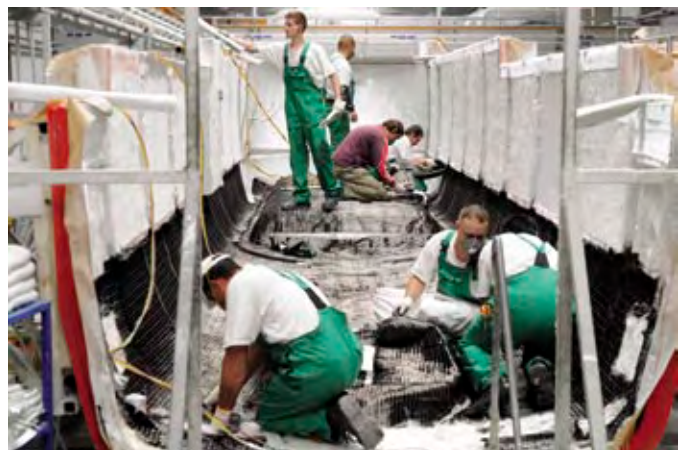
Karbon- és üvegszövet terítése
