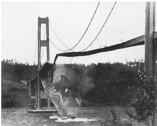
1. ábra: a Tacoma-híd katasztrófája
