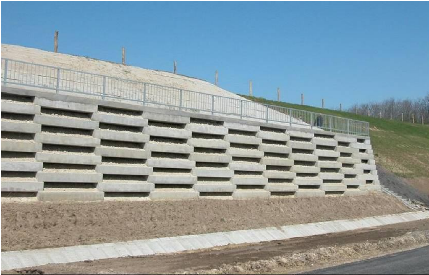
M7 autópálya Bszárszó – Ordacsehi Homlokelemes erősített talajtámfal TENSAR – GRADEX Kft.
