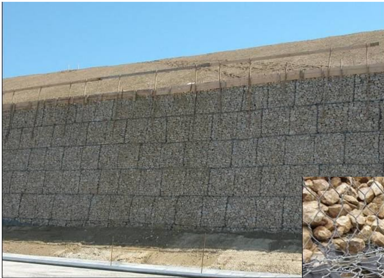
M7 autópálya Bszárszó – Ordacsehi Terra-Mesh támfal Pannon-Freyssinet
