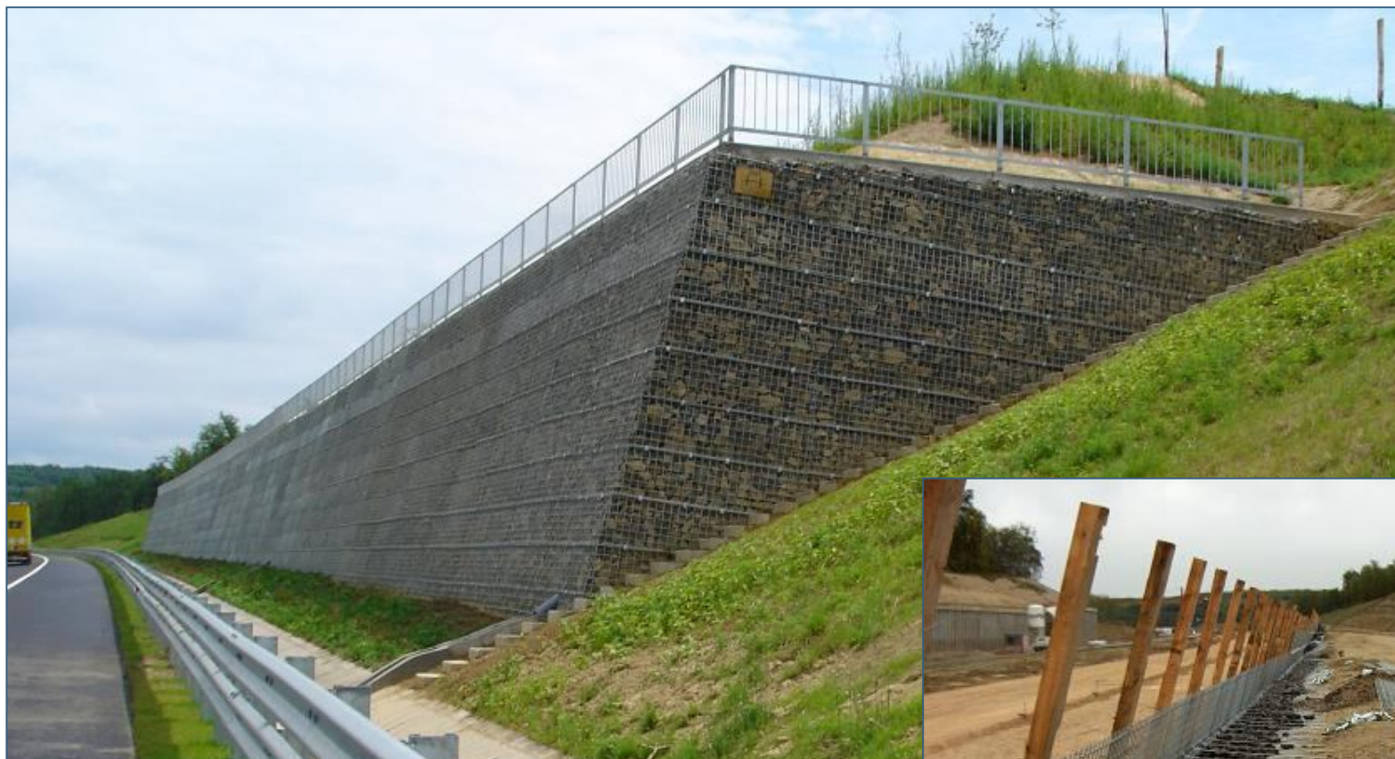
M7 autópálya Bszárszó – Ordacsehi Terra-Trail támfal Pannon-Freyssinet
