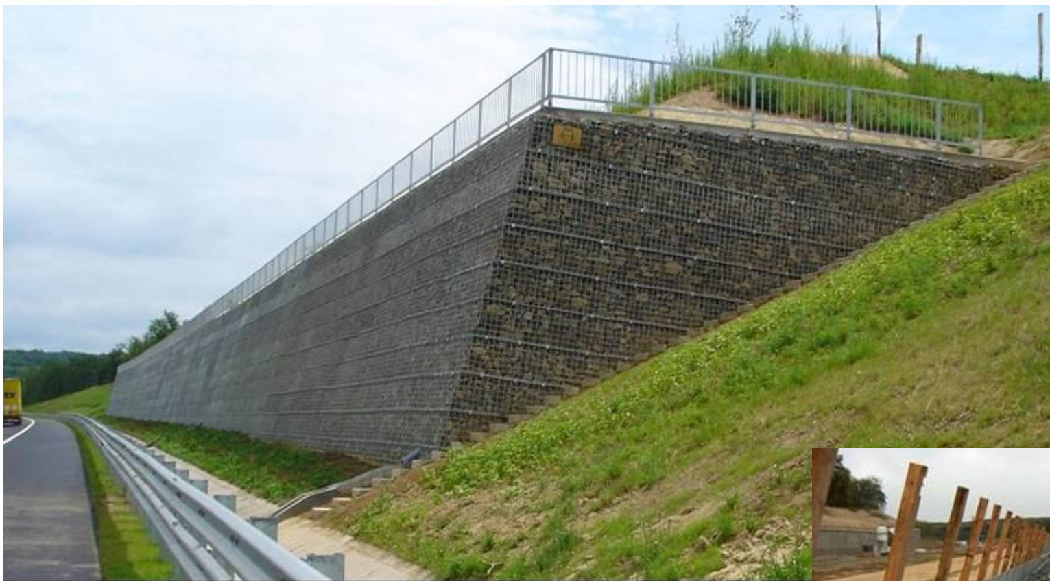
M7 autópálya Bszárszó – Ordacsehi Terra-Trel támfal Pannon-Freyssinet
