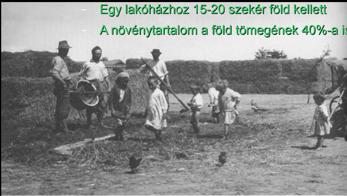
Sártaposás gyerekek közreműködésével. A háttérben rakott sárfalú épülő házak (Nyíradony, 1933)
