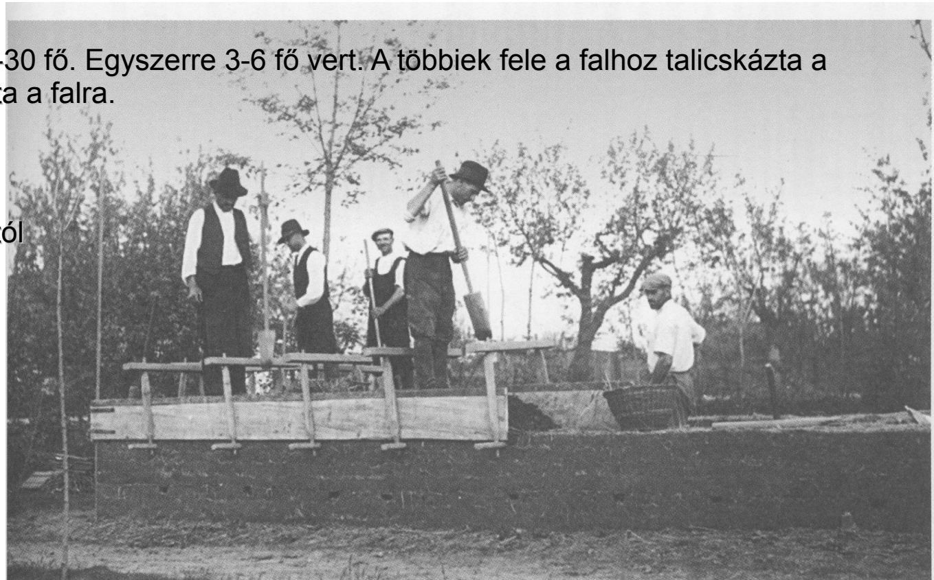
Kalodás vert fal készítése (Békés, 20. sz. eleje)
