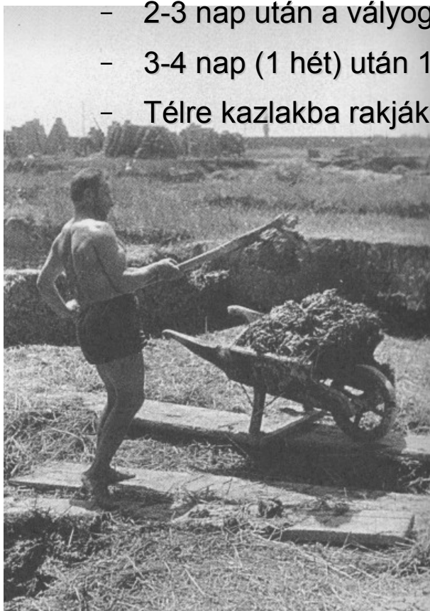
Sárkészítés vályogvetéshez (Karcag, 1958)
