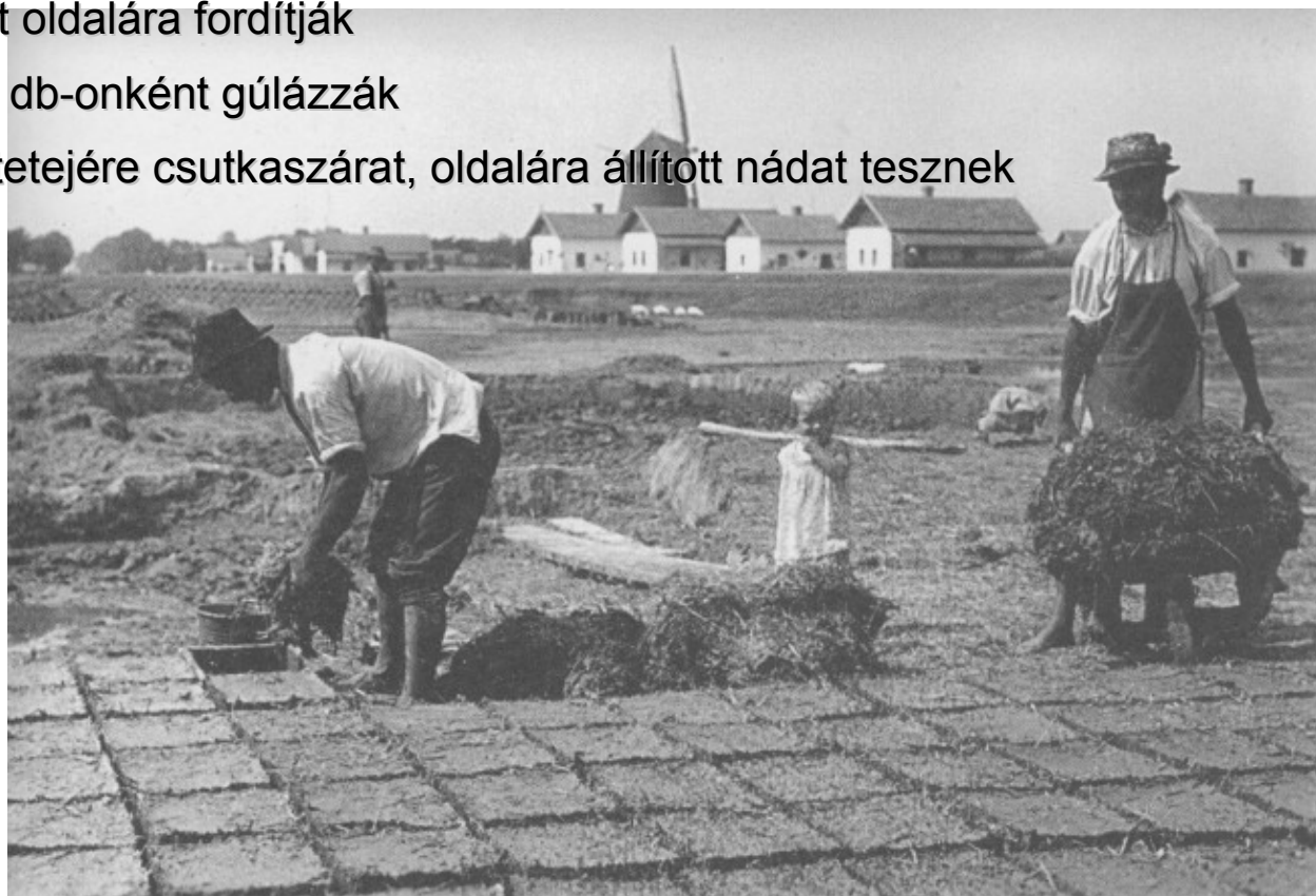
Vályogvetés. A sarat kézzel tömik a formába (Karcag, 1934)
