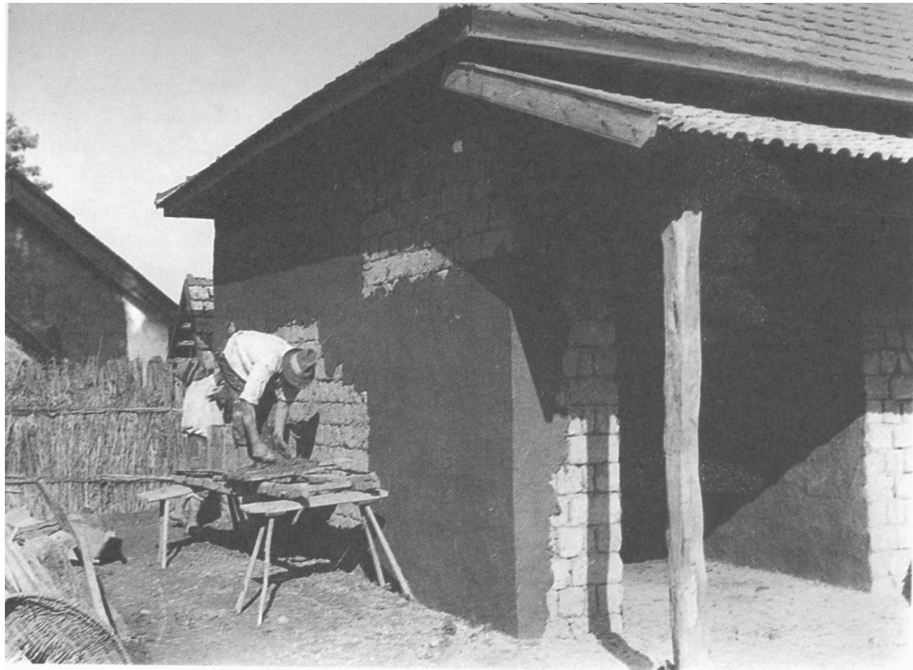
Vályogfal tapasztása (Tiszaszőlős, 1938)
