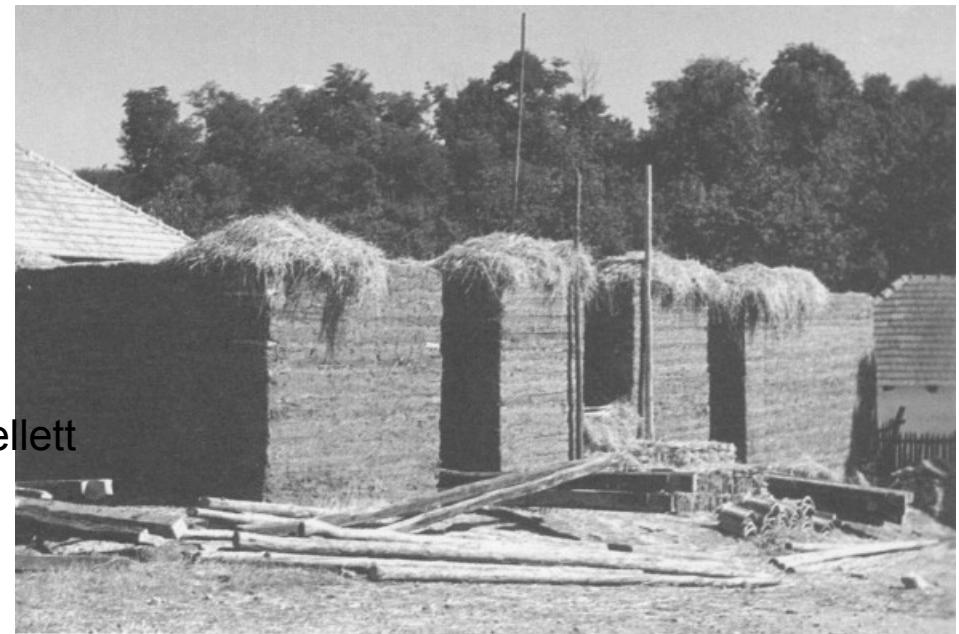
Vert falú ház építése. A falakat szalmával takarják le (Borsodszemere, 1955)
