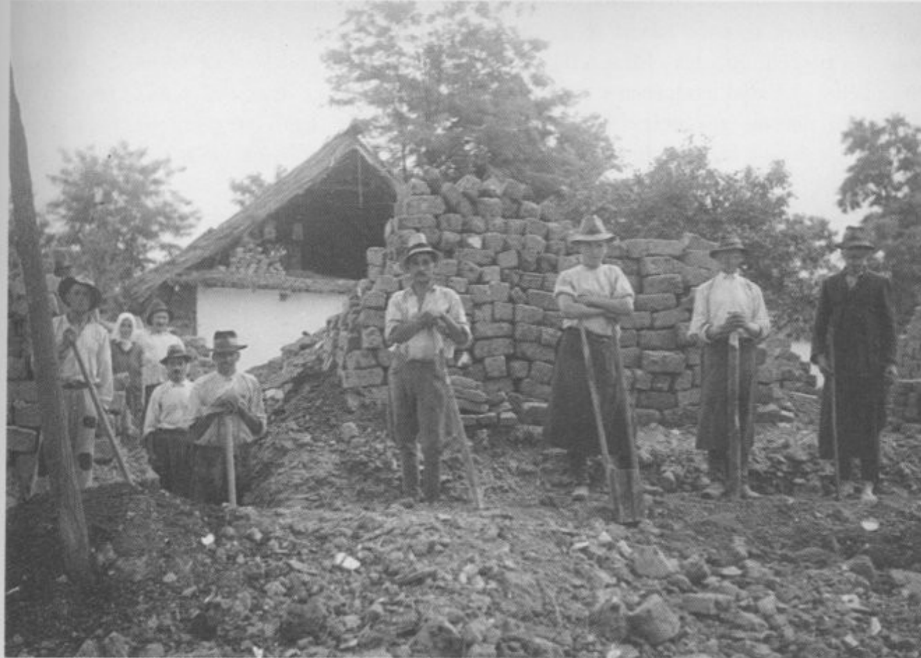
Vályogház alapozása. A kiásott alapárkot (bal oldal) erősen visszadöngölik (előtér) (Bojt)
