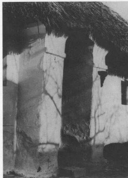
16. kép. Konyhai bejárat ajtó előtti boltozata. Sérfenyősziget (Győr-Moson-Sopron m. – ma Dunasziget része), 1960.
