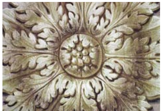
37. kép. Rozetta-stukkó imitáció, vegyes szekkkó technikával. A világos színek mésszel készültek, a sötétek talán enyvvel.
