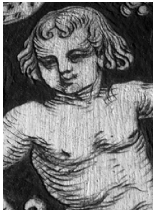
16. ábra. Sgraffito (lásd 15. ábra) felületének szerkezete. A súrló fényben jól láthatók a vastag meszelés rétegek és a kivágtott vakolat felületi jellegzetességei.
