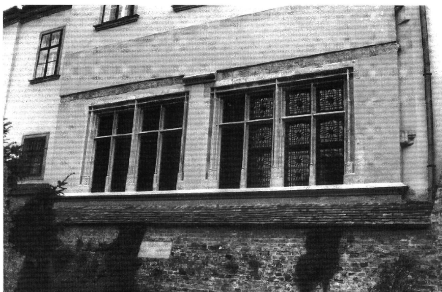
9. ábra: Az ablakok helyreállítás után
