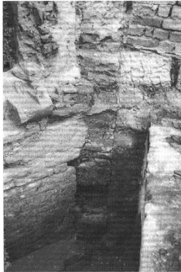
6. ábra: A kaputorony, a nekiépített déli építmény és a Dóczy kápolna csatlakozása, utóbbi falában a felvonóhidas kapu perselyes konzolköve
