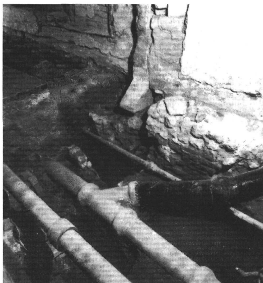
2. ábra: Az ülőfülkés kapualj északi kerékvetője, alatta a korábbi épület falmaradványa ill. a kaputorony fala a csatlakozó csatorna maradványával
