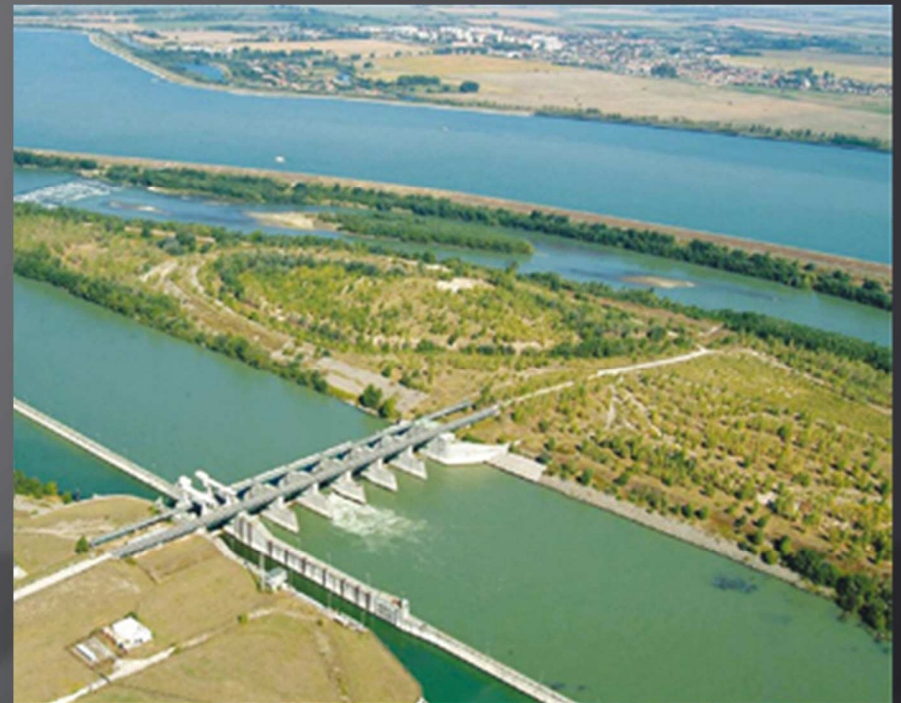
Bősi vízerőmű (720 MW)
