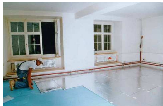
8. Ábra: Födém hőszigetelése VIP-el
