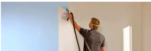
20. Ábra: Felhordás vákuumos porlasztóval
