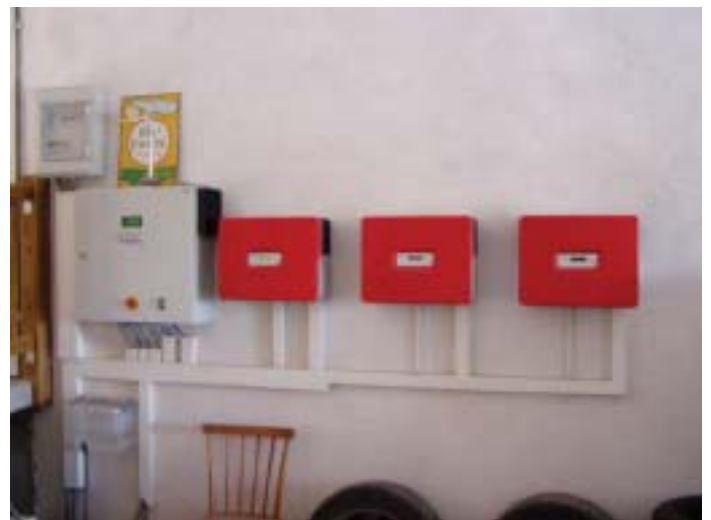
Piros: irányító szerkezet, fehér: átalakító
