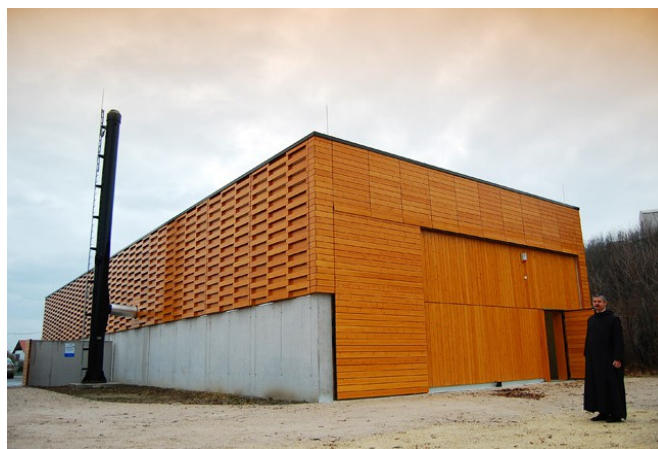
6. Kép: A Pannonhalmi Apátság biomassza üzem építészeti értékekkel is bír
