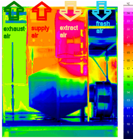
12. Ábra: hővisszanyerős szellőző működés közben
