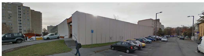
8. Ábra: Északi homlokzat/kerítés felújítása pályázati forrásból
