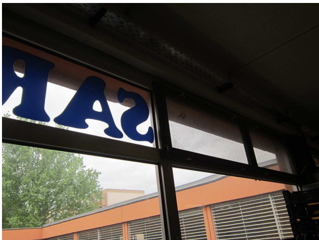
6. Ábra: Utólagosan beépített fa bukó ablak
