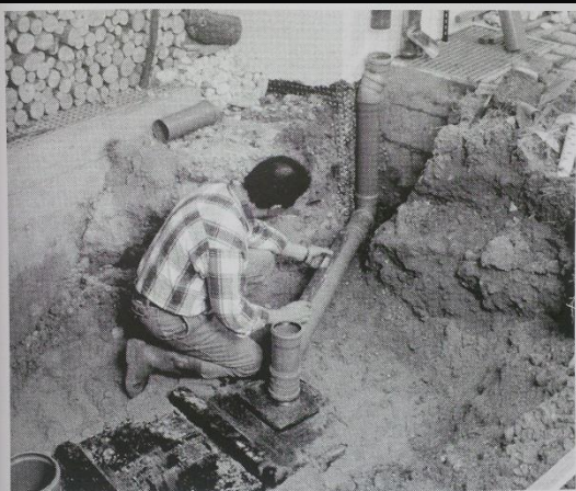
26. ábra. Az esővizet levezető ejtőcsövet és a föld alatti esővíztározót összekötő KG cső szerelése (Forrás: Alko)
