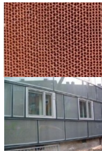
3.16 ábrák- Működési elv, szoláris felújítás papír hullámkarton anyagú transzparens hőszigeteléssel
