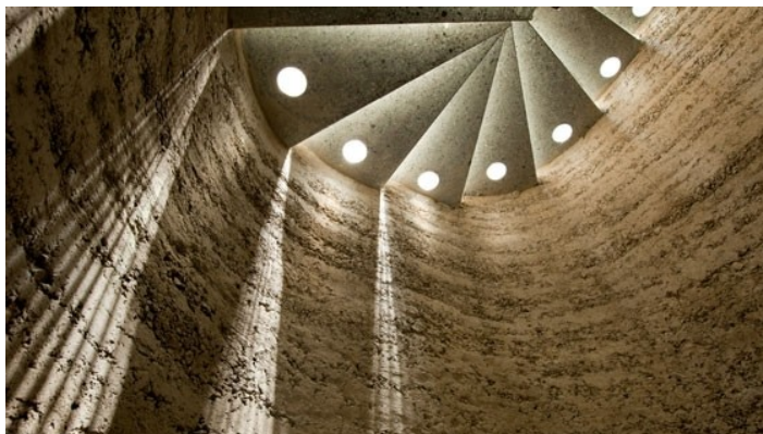
20. Kép: Cementtel stabilizált vályog [17]
