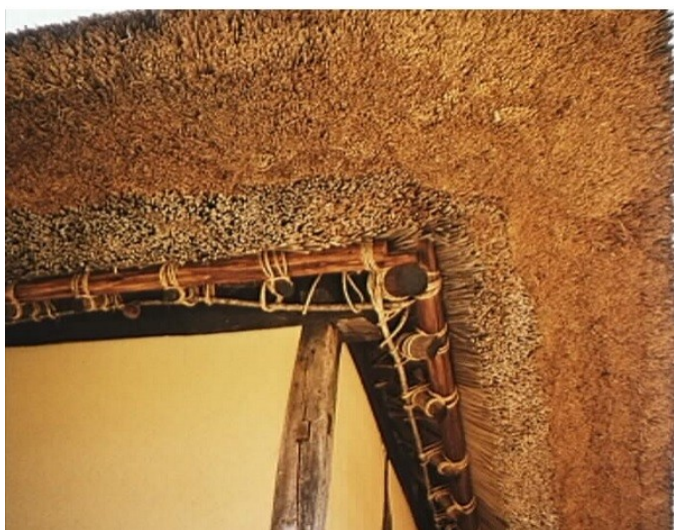
26. Kép: A tetőfedés kender kóróból készült, kötéshez is kender rostot használtak
