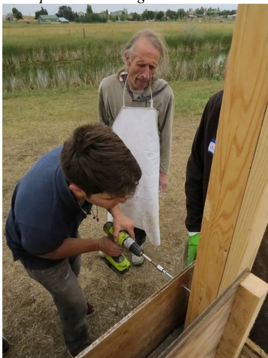
13. Kép: Zsalutábla rögzítése
