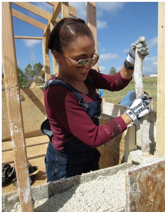
14. Kép: Tömörítés fa döngölővel
