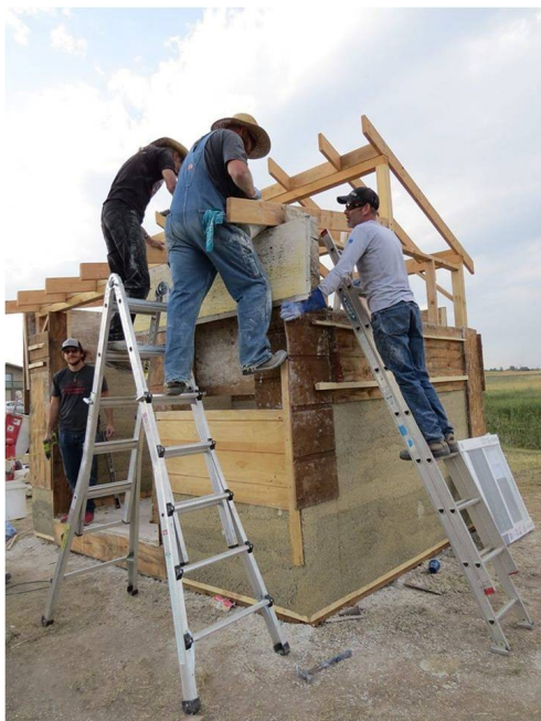
12. Kép: Tömörítési technológia
