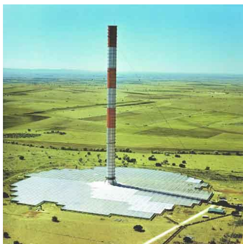
A prototípus termikerőmű Manzanares-ben, jobbra a turbina [9]
