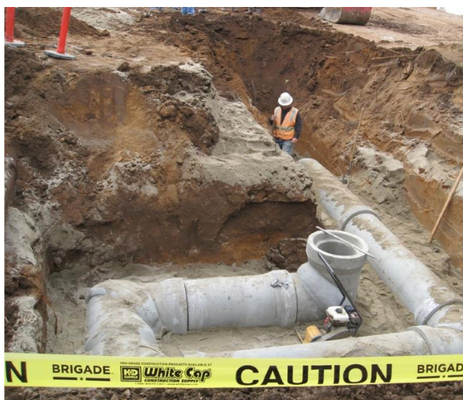
A földalatti betoncső építés közben és a talajszinti szellőzőnyílások terve [15]
