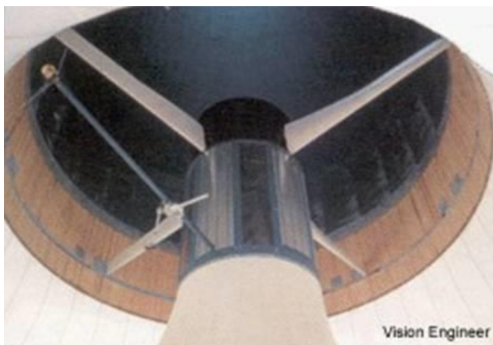
A prototípus termikerőmű Manzanares-ben, jobbra a turbina [9]
