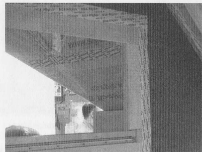
4. kép Hőszigetelés szélzáró lezárása
