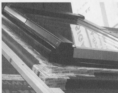
11. kép Hőszigetelt lépcsős magasító kerettel beépített tetőablak
