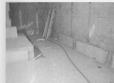
8. kép A felületfolytonos csatlakoztatás érdekében előre elhelyezett pára- és légzáró fólia
