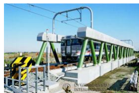
A látszat csal... Ez egy feszített vasbeton teknőhíd!
