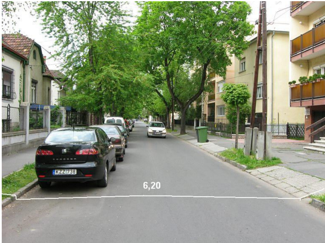
3. ábra. Lakóutca, kb. 1500 E/nap forgalommal. A kétirányú utcában erős lassítással vagy a kocsifelhajtókra való kitéréssel lehet elviselni a kétirányú forgalmat és az egyoldali parkolást. (Győr, Babits M. u. északi szakasza)
