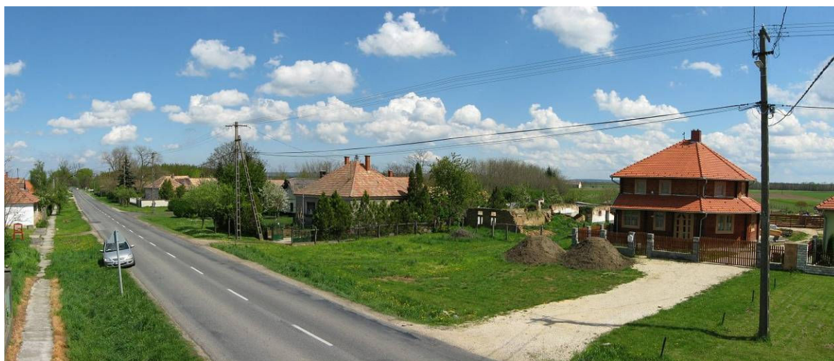
5. ábra. Orsó formájú tér félbehagyott szűkítése (Tét-Tétszentkút)
