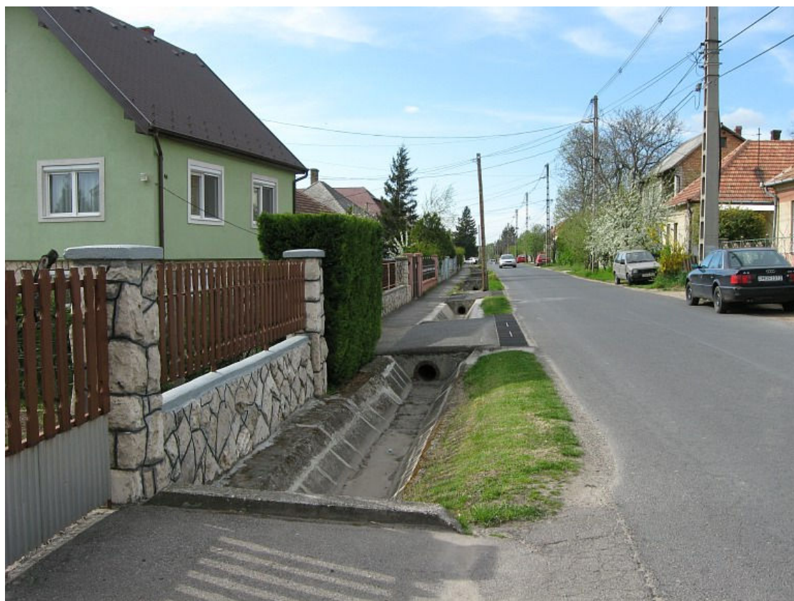
4. ábra. Helyszínrajzi és magassági összhang-hiány a vízvezetés és a járdaépítés között. (Győr-Ménfőcsanak, Ménfői u. északi szakasza)
