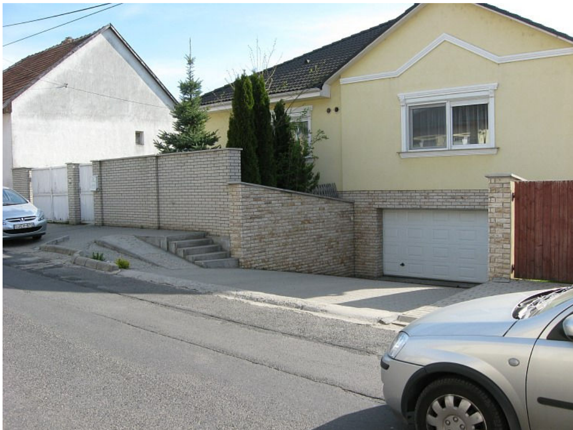
6. ábra. A gyalogosok mozgását nagymértékben nehezíti a magasságilag koordinálatlan külszöbbszintekkel megépített négy új kapuhoz igazodó járda. (Győr, Zichy O. utca)
