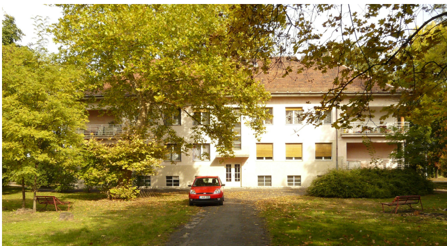
12. ábra: Vezetői lakások a MOL telephez tartozó szolgálati lakótelepen (MOLAJ), amelynek kiépítése is megkezdődött a 40-es évek első felében.
