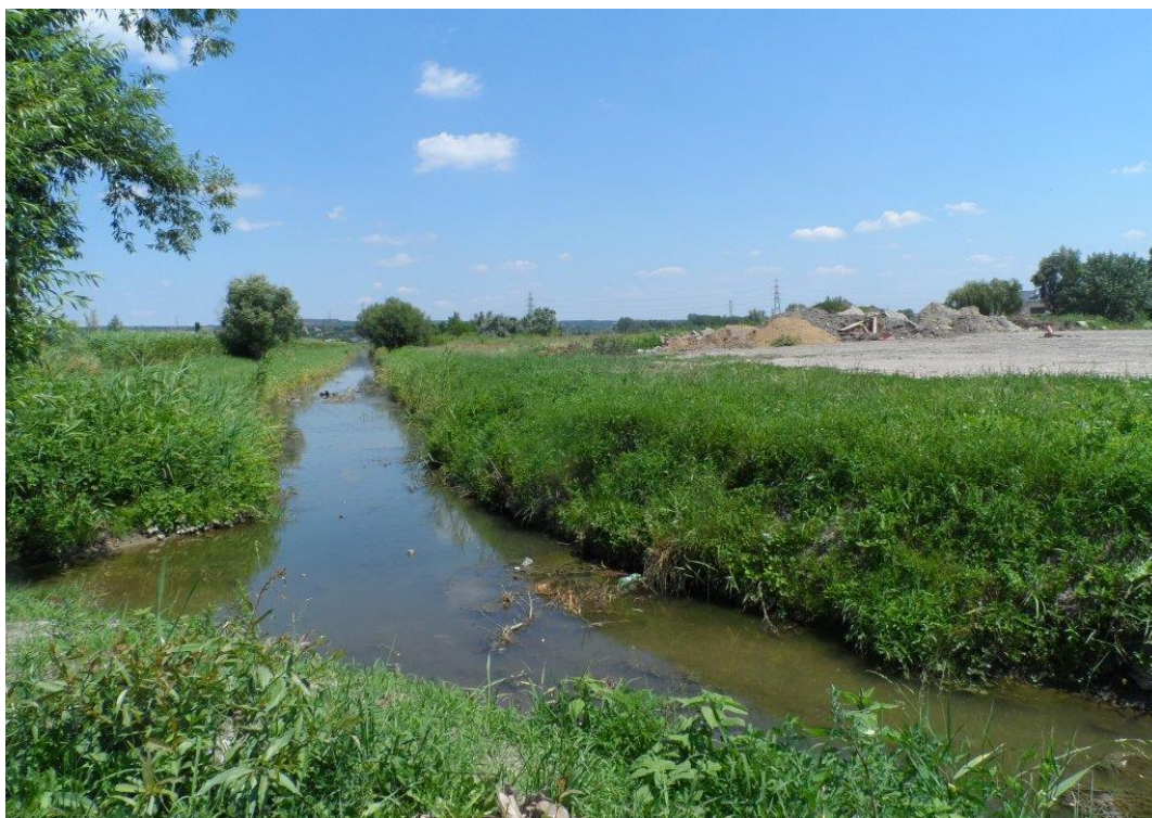
Az Érd-Diósi vízfolyás délnyugati (kifolyó) szakasza, jobb oldalon a törmelékfeltöltés
