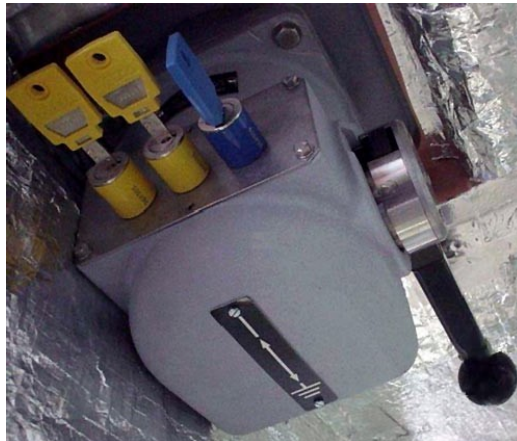
42. ábra: Földelőkapcsoló (földelt állásban)
