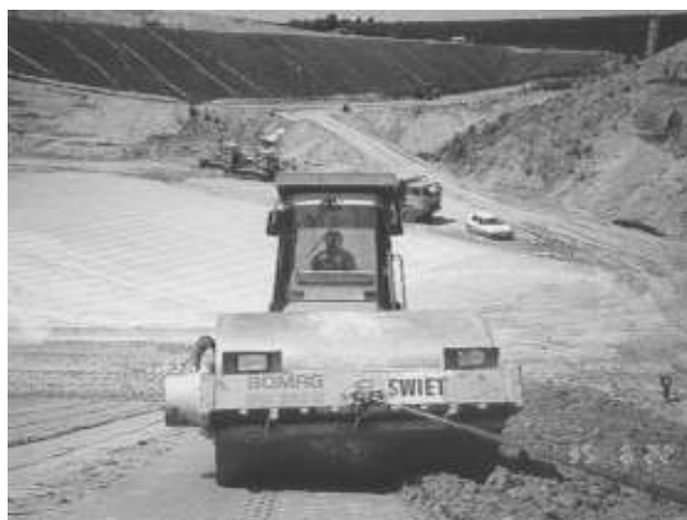
9.2. ábra. Hulladéklerakó szigetelő aljzatának építése geoműanyagok alkalmazásával.
