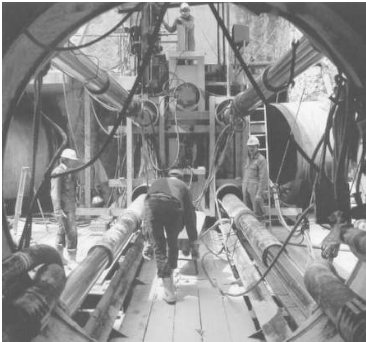
11.29. ábra. Csősajtoló akna és a hidraulikus sajtók
