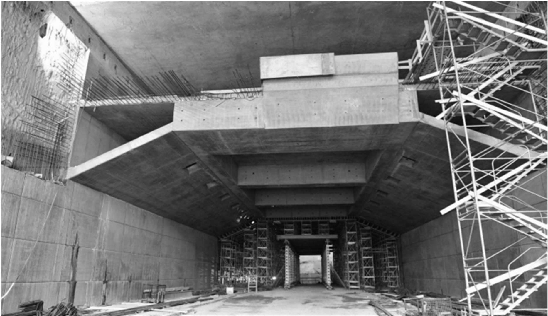
Metróállomás kelenföldi pályaudvar
