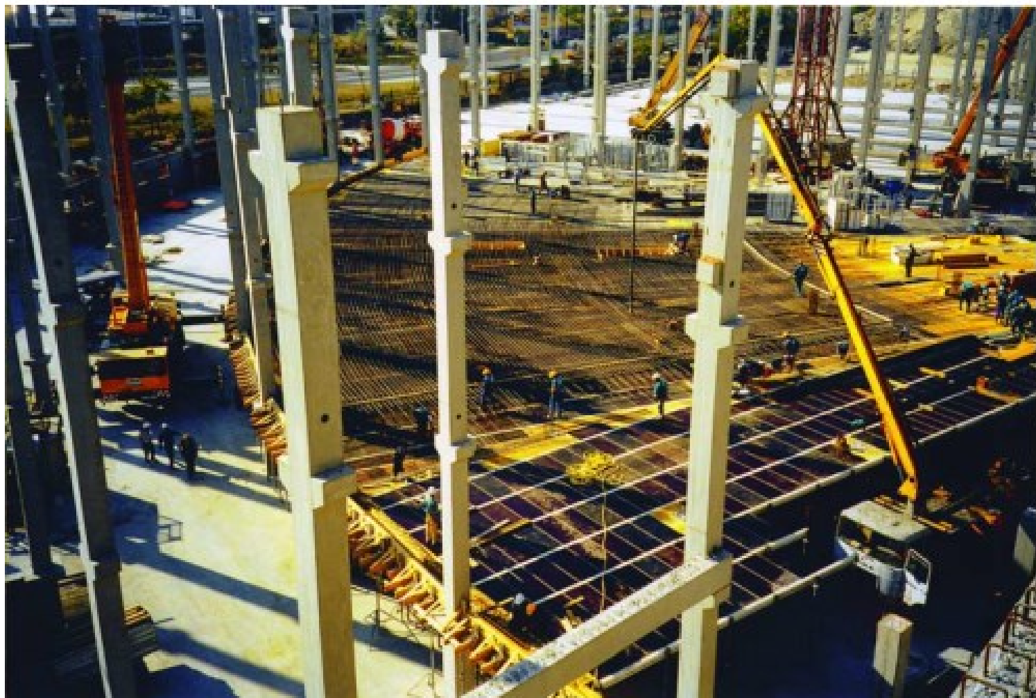
Előregyártott pillérvázás épületszerkezet, íves peremgerendás födémének zsaluzása, födémemeles, ejtőfejes alumínium zsaluzati rendszerrel (Budapest: Lurdy bevásárló központ)
