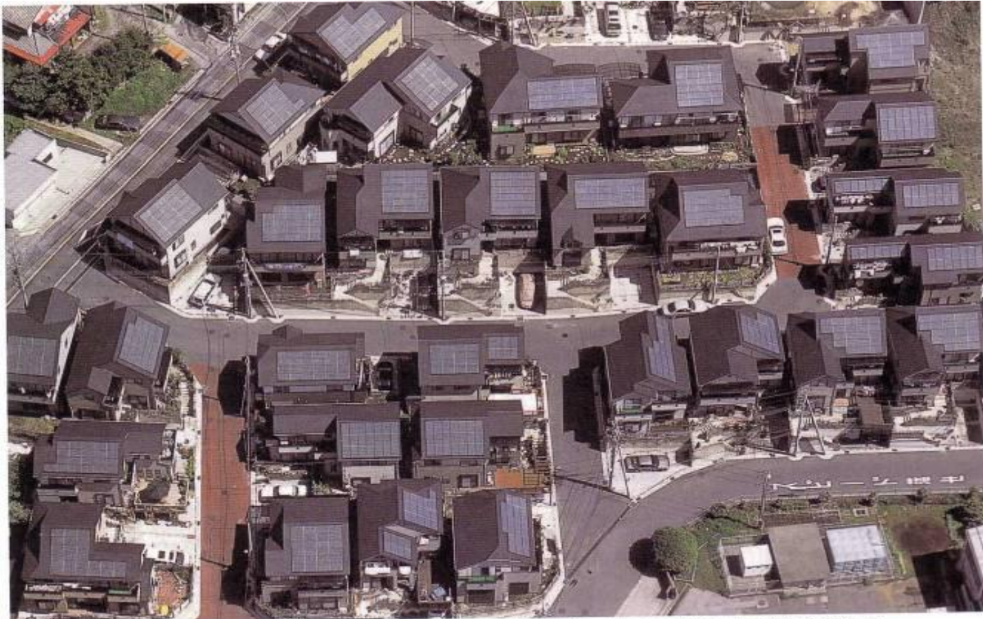
Il villaggio di Matsudo, esempio giapponese di integrazione urbanistica del fv nelle coperture delle abitazioni private
